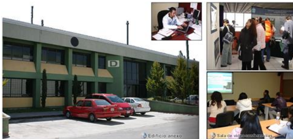
Figura 10. Instalaciones del edificio “D” o “anexo”.
