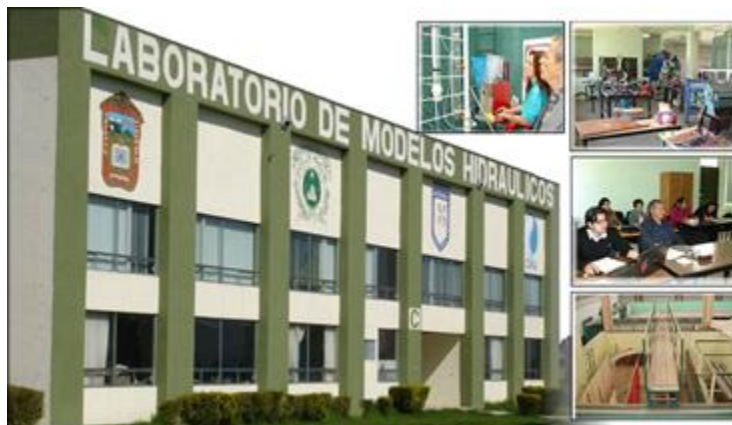
Figura 9. Instalaciones del Laboratorio de Modelos Hidráulicos
