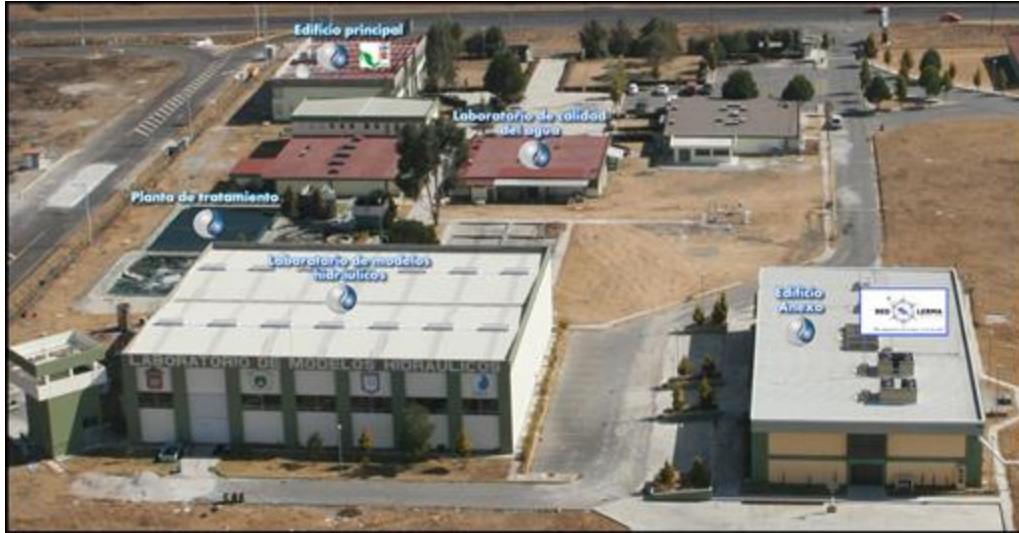
Figura 6. Instalaciones del IITCA
